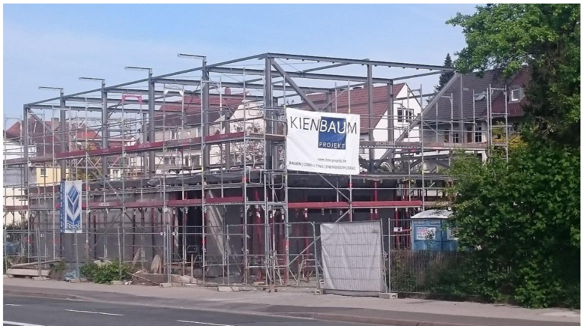
Bild 5 „Gemeinsame Besichtigung der Baustelle“
